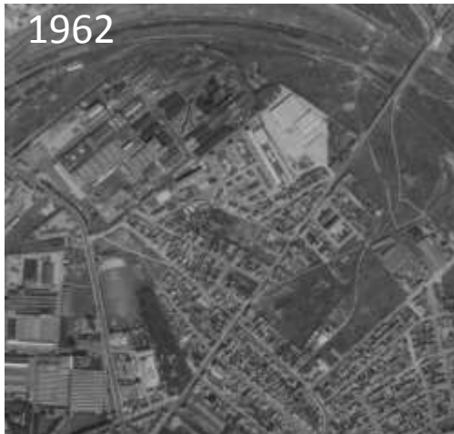
Construction des logements sociaux et à l'Est de la route de Bétheny Industrialisation au Nord et création de la rue Camille Guérin
